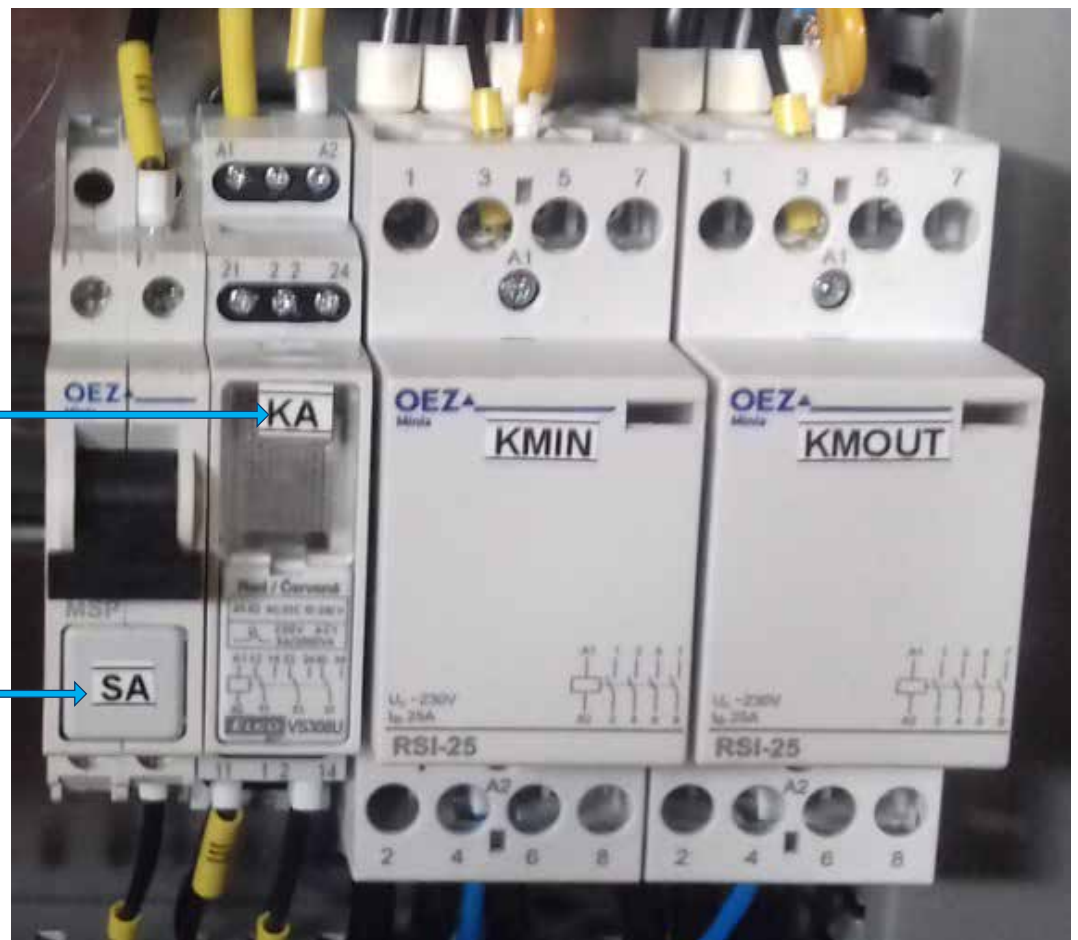
Obr. 30 – ukázka spínače režimů integrovaného By-passu
